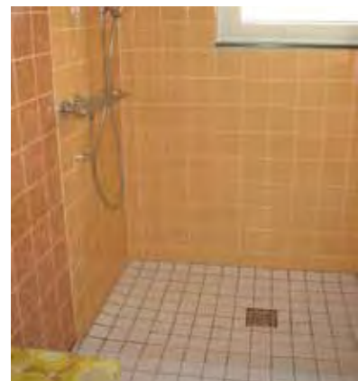
Aus der Wanne wurde eine bodengleiche Dusche.
